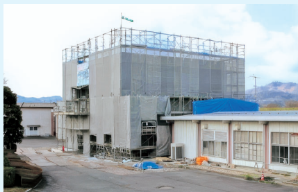
新築中の自家発電機棟 (2階建て) (写真中央: 令和6年3月現在)
