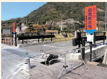
応急給水栓 (鳥取西高校前)
