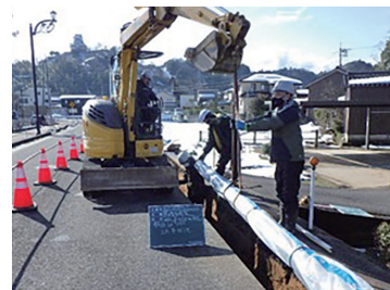
耐震管への布設替え工事
