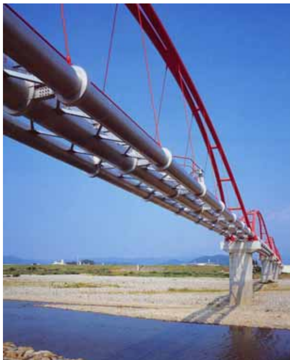
写真 2-8 導水施設(水管橋)
