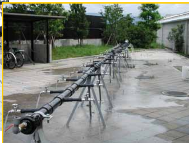
写真 2-13 応急給水拠点と仮設給水栓
