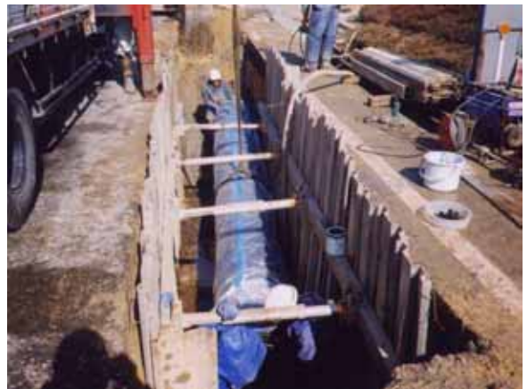
写真 2-12 管路布設工事
