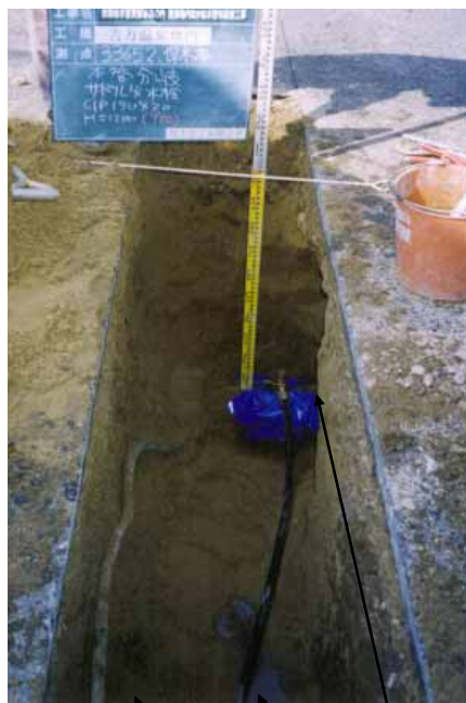
既設配水管 更新ポリエチレン管 既設鉛製給水管
