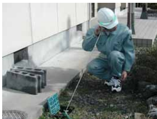
写真 2-17 宅地内漏水調査
