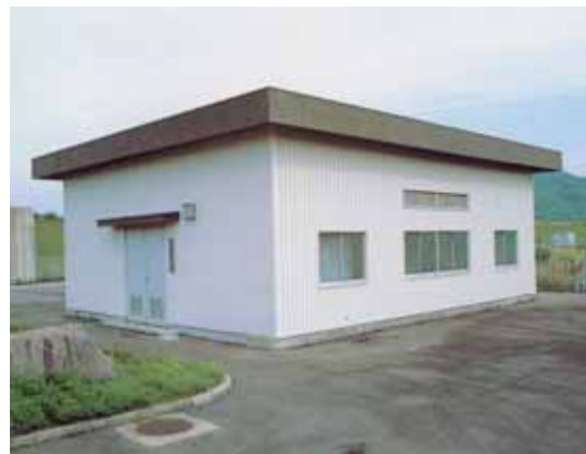
写真 3-2 向国安水源地
