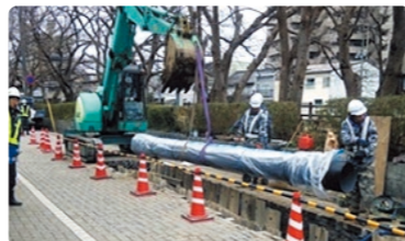
耐震管に取り替える工事
