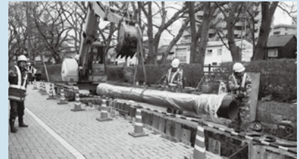
管路の新設工事の様子
