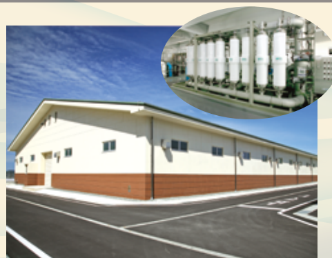
江山浄水場内の浄水棟と膜ろ過ユニット
