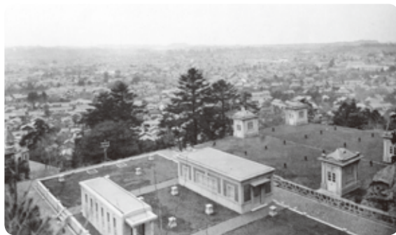
長田山配水池
