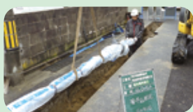
耐震管の布設工事
