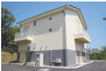
▲城山浄水場(施設能力:2400m 3 /日)
