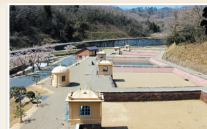
現在の旧美歎水源地水道施設
