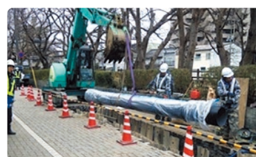
耐震管に取り替える工事
