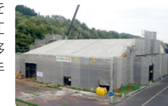
建設中の水質検査室
