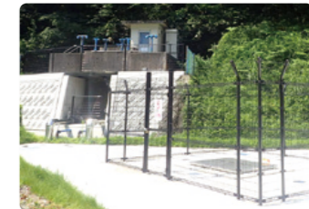
施設整備を行った上安蔵浄水場
