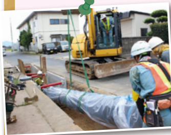
新しい管路(耐震管)への取替工事
