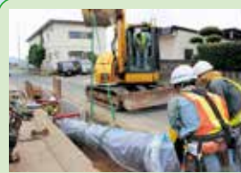
耐震管への布設替工事
