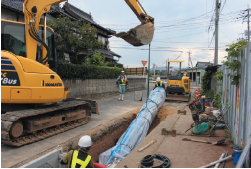
耐震管への布設替工事
