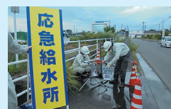
飲料水供給栓の設置訓練 (千代水スポーツ広場)
