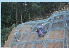
上町配水地斜面安定工事
