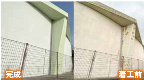
上町配水池:容量10,000m 3 外壁改修を行い、施設の長寿命化を図りました。
