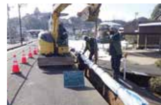
送水管布設工事(河原地域)
