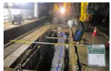
送水管布設替え工事（古海地内）
