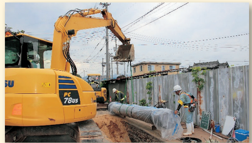
水道工事の様子
