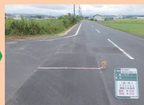
④再度掘削して古い水道管を撤去し、本舗装
