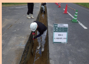
②水道管布設後、埋め戻し
