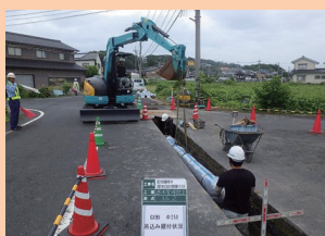
①掘削し水道管を布設
