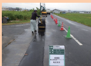
③作業終了前の仮舗装
